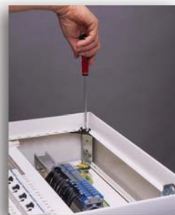
Быстрое выполнение сборки при помощи четырех винтов
