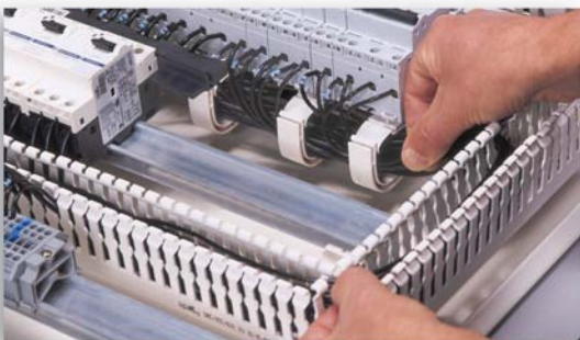
Прокладка кабеля при помощи вертикального кабельного канала, хомутов
