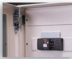
Чёткая разметка и расположенные на одном уровне заглушки способствуют тщательности отделки
